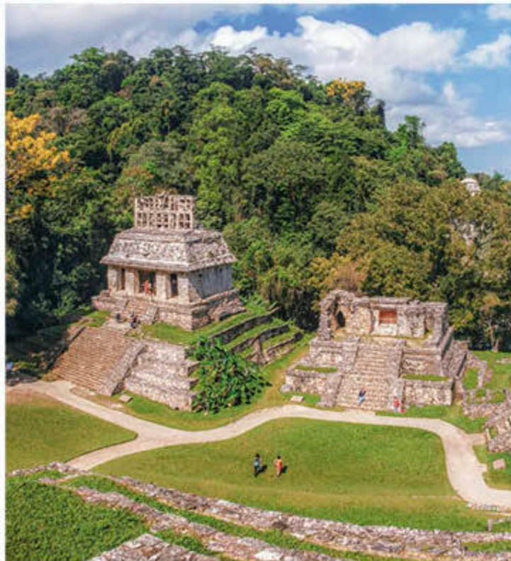
Figura 6.1 La zona arqueológica de Palenque aún conserva muchas construcciones originales, lo que denota la fortaleza de su arquitectura y la planeación urbanística de la ciudad.
